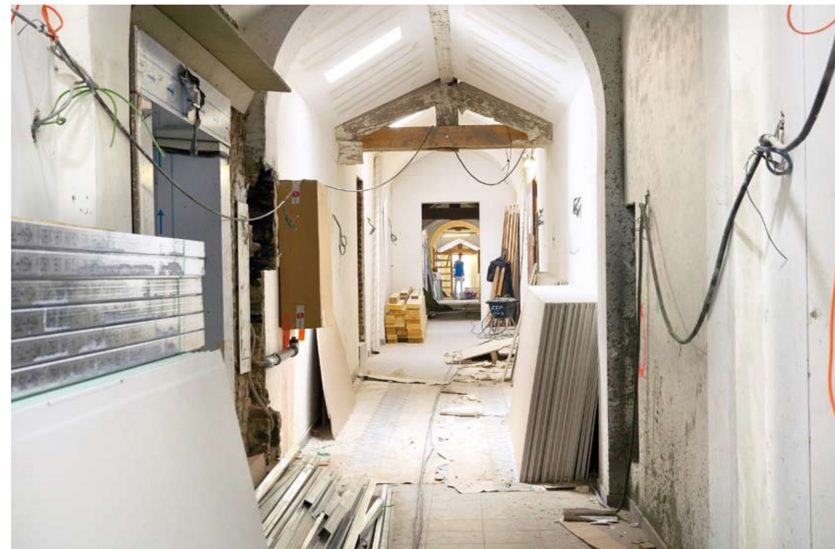
Travaux de restauration importants du 4 e étage du 16, rue de la Loi, où sera installée, entre autres, la nouvelle salle du Conseil des ministres.
